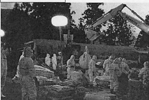
埋却作業現場
