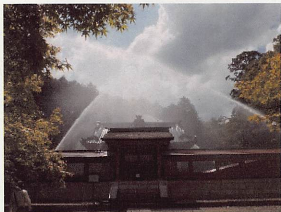
設置した消火設備の放水訓練
