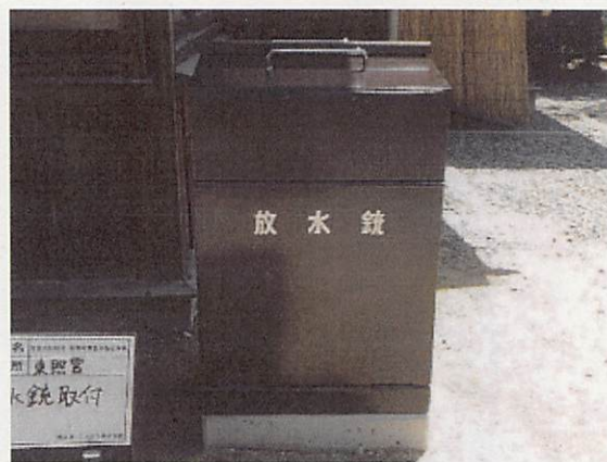
消火設備 放水銃の設置
