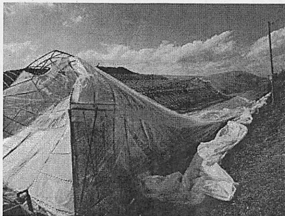
台風による農業用ビニルハウスの倒壊 (2018年9月の台風21号)
