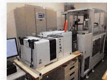
かび臭物質連続測定装置 (南津田導水ポンプ場)
