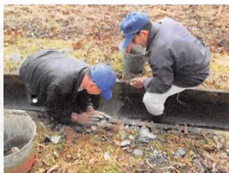
末端用水路の目地補修で漏水防止
