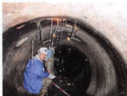
幹線用水路の更新整備
