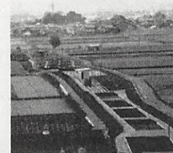
【図表1-10】山寺川市街地排水浄化施設「伯母川ピオパーク」
