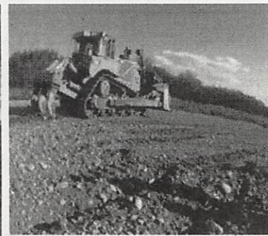
【図表7-3】細粒分の流下促進によるアユの産卵環境の改善のための愛知川固定化砂州におけるアーモアコート破壊（河床耕耘）事業
