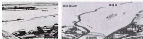
昭和28(1953)年台風13号による被害 1死者 約200名、浸水家屋約213,000戸、浸水面積約103,000ha
