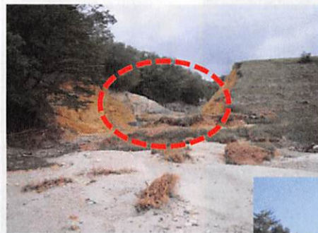
平成29年の台風21号によるため池堤体の決壊(甲賀市)
