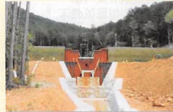
砂防堰堤(野洲市三上) (避難所の保全)
