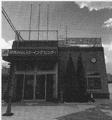
管理棟・艇庫入口を撮影
