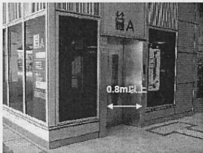
エレベーター
