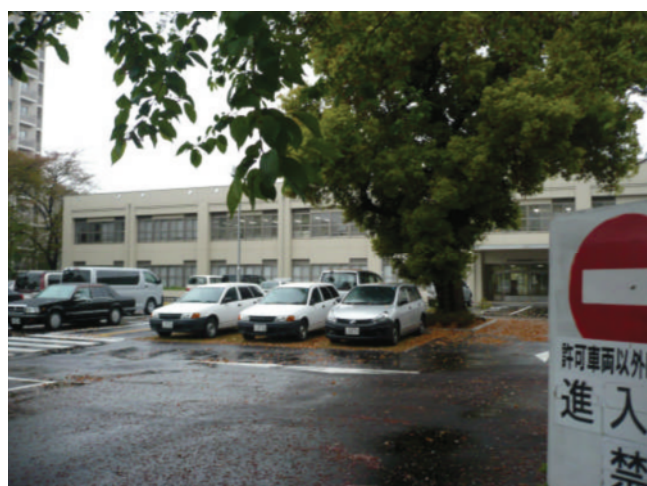
参考) 埼玉県危機管理防災センター 施設概観
