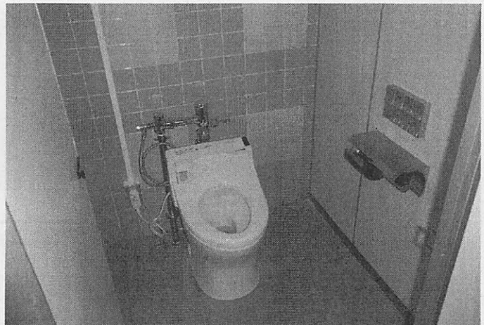
図 八日市駅におけるトイレの改修
