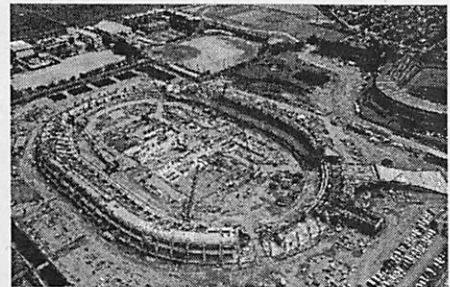
（（仮称）彦根総合運動公園 整備状況（令和3年8月）
