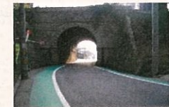
大沙川(天井川)
