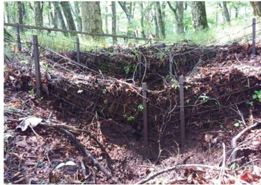
図 4.1.2 金網柵工の施工例
