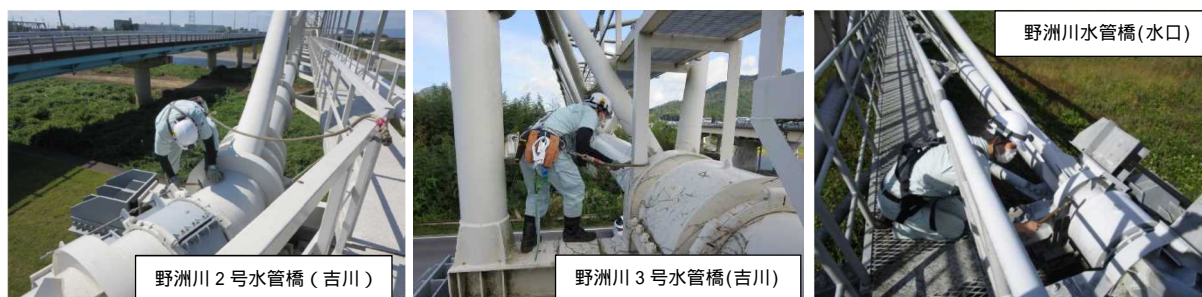
写真：緊急点検実施状況 (R3.10.5)
