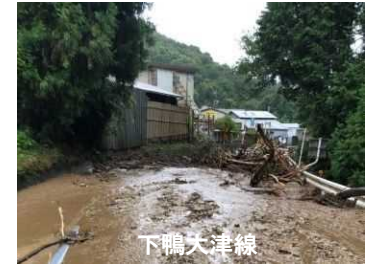
図 2021年8月の台風18号による道路被害状況
