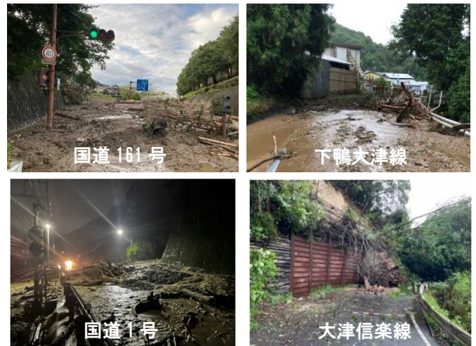
2021年8月の台風18号による道路被害状況
