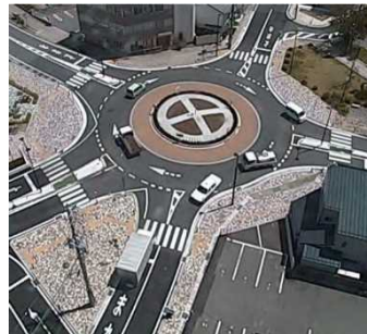
28 環状交差点(ラウンドアバウト)の事例(飯田市東和町)(国土交通省)
