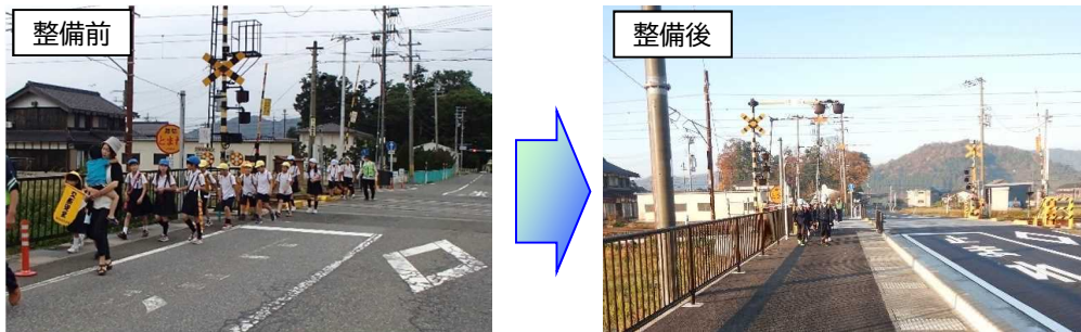
20 通学路の安全確保のため踏切前後の歩道を整備した事例
