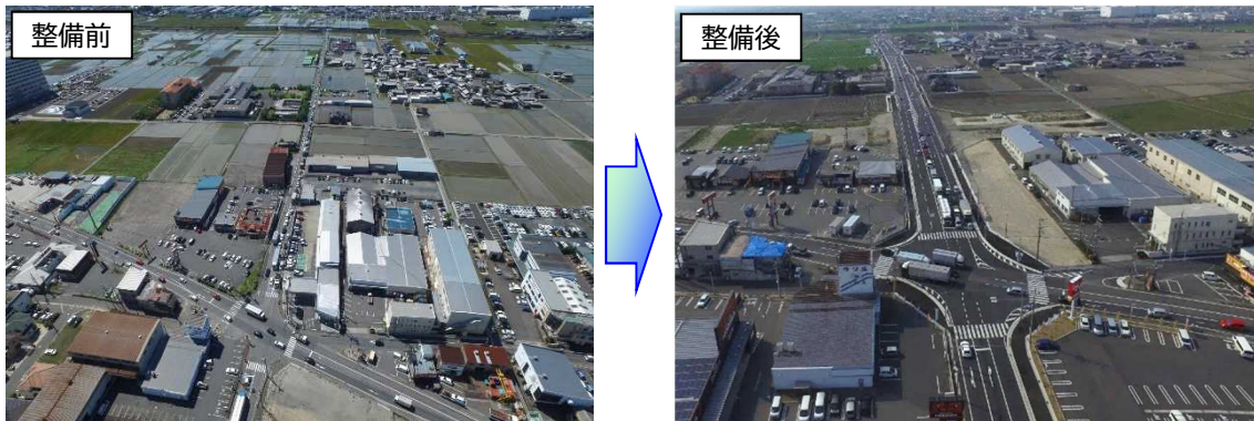
4車線化により渋滞解消を図った道路整備の事例 一般県道 片岡栗東線(栗東市)
