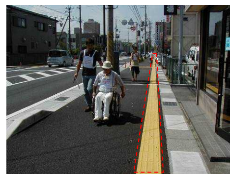
通行の支障を解消した事例 (大津能登川長浜線(守山市))
