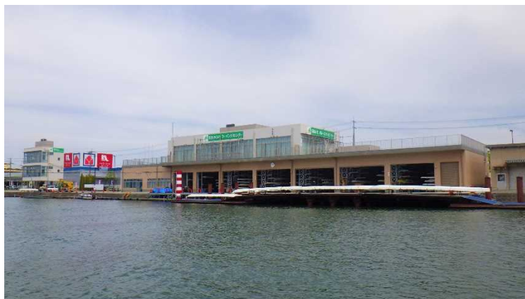
管理棟・艇庫を琵琶湖から撮影
