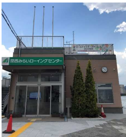
管理棟・艇庫入口を撮影
