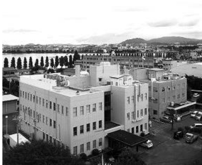
滋賀県衛生科学センター全景
