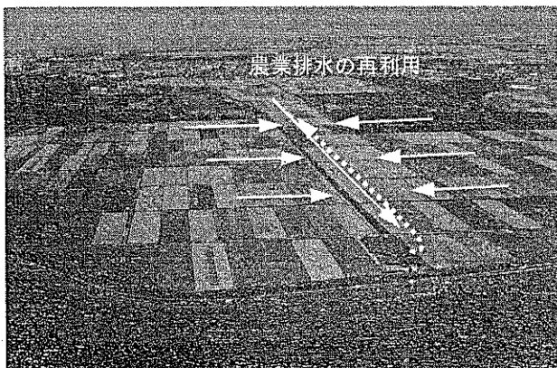
循環かんがい施設の例(木浜地区)
