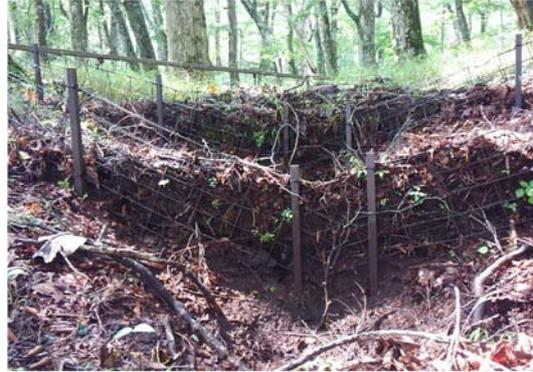
図 4.1.2 金網柵工の施工例
