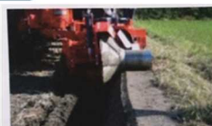
あぜ塗り機による 補強（漏水防止）
