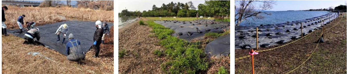
遮光シートの敷設：ヨシ混生地と砂浜湖岸（枯殺事業）、湖岸緑地の石組み護岸（第8号対策事業）
