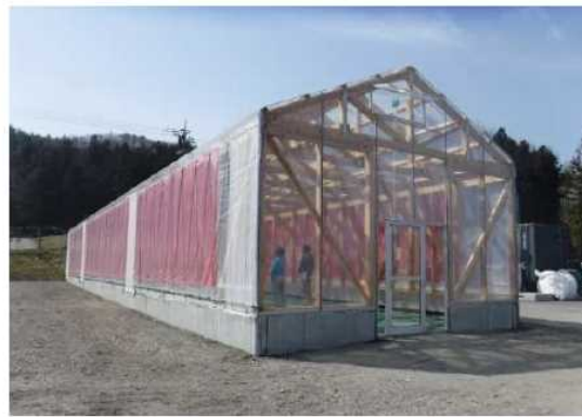
地域材を利用した木造農業ハウス
