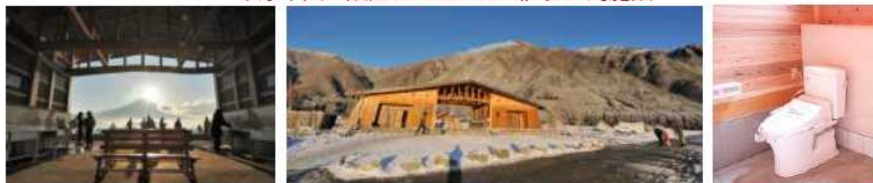
草原中央に設置されたトイレ 兼 多目的施設
