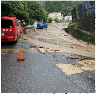
下鴨大津線【規制雨量超過】 土砂流出(南滋賀町)
