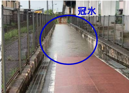
安土西生来線 冠水(下豊浦:JR地下道(歩道))
