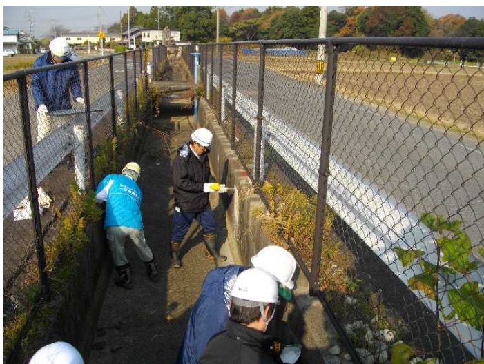
機能診断調査の状況
