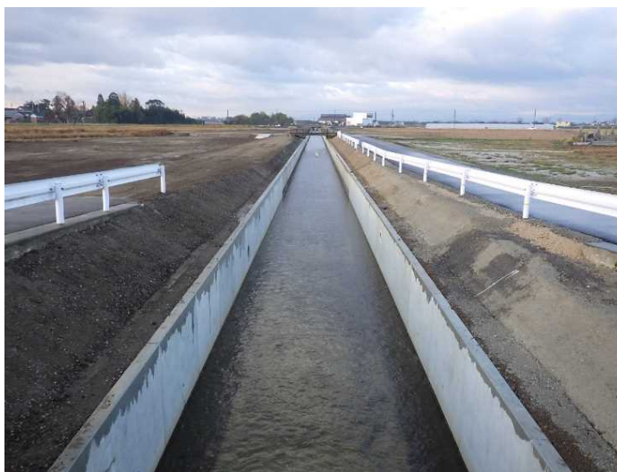
国土強靱化対策（排水路改修）
