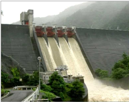
永源寺ダムの洪水吐放流
