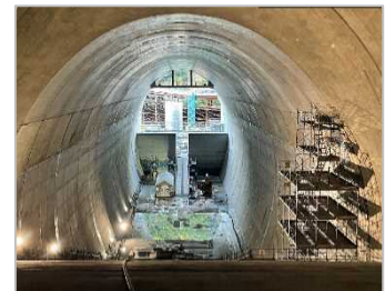
天ヶ瀬ダムの洪水放流設備（京都府） （建設中）出典：近畿地方整備局 HP Amasaidam_position.pdf (mlit.go.jp)
