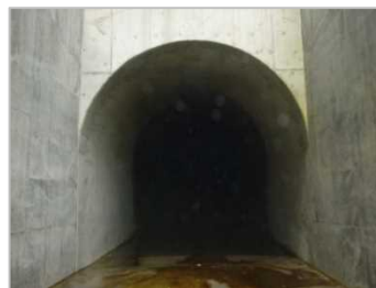
松川ダムの排砂バイパス（長野県） 出典：長野県建設部 提供
