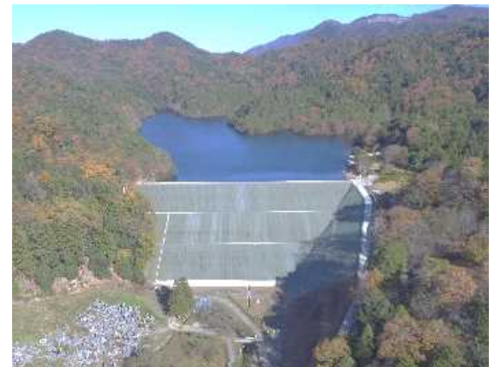
改修が完了した芹川ダム (R3.12 多賀町)
