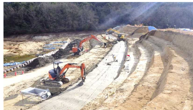
改修中の横在戸池 (R4.1 大津市)
