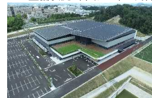
（滋賀アリーナ整備状況（令和4年8月））
