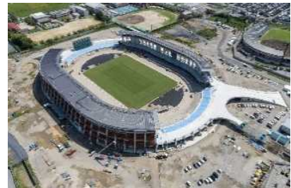
（彦根総合スポーツ公園整備状況（令和4年8月））
