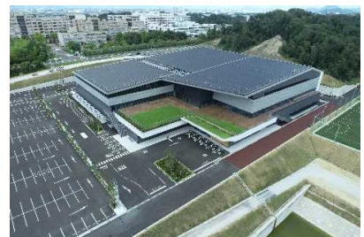
（滋賀アリーナ整備状況（令和4年8月））
