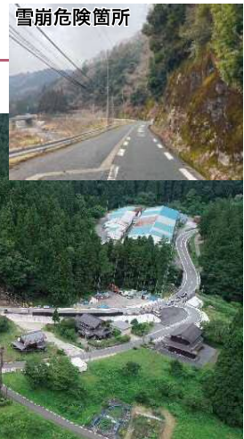
雪崩危険箇所
