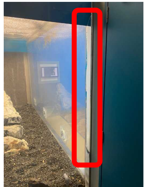
裏側（左側）からみた水槽
