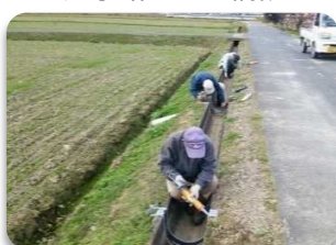
■用水路の目地補修
