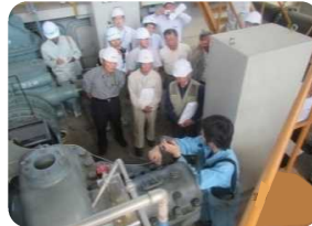
■現地研修(ポンプ設備)
