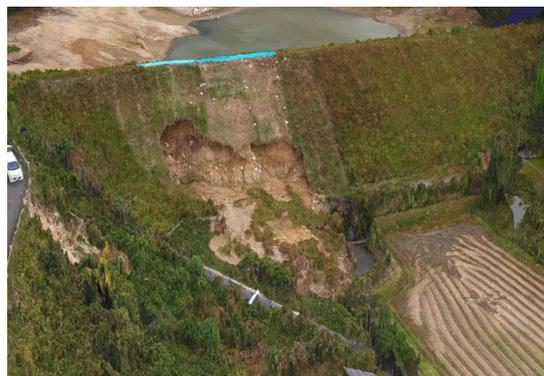
図VI-4 貯水位の上昇によりパイピング破壊したため池（他県例）
