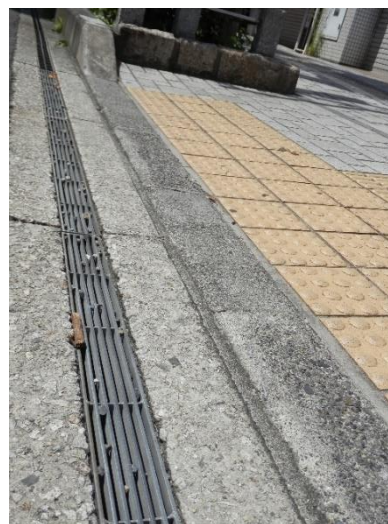
画像8 車道との段差に配慮した歩道
