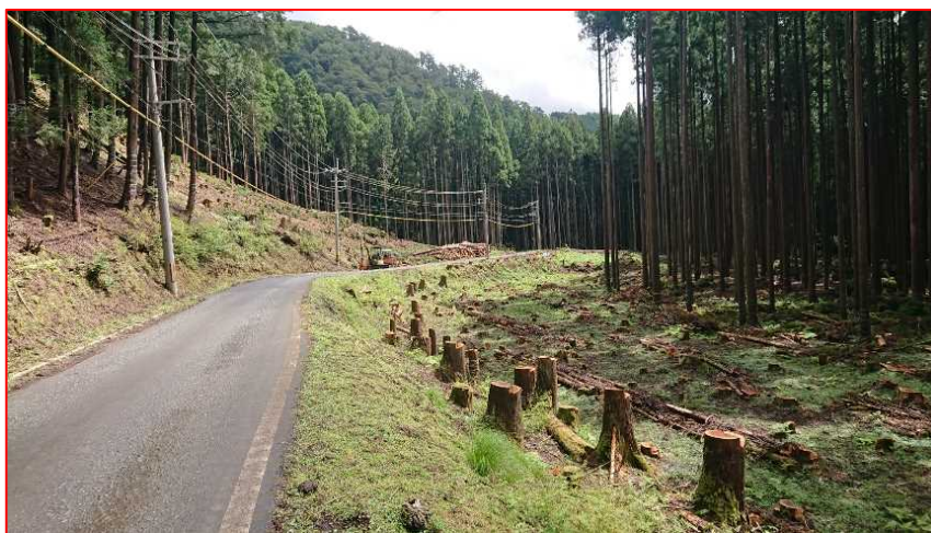
道路沿いの予防伐採を行った現場
