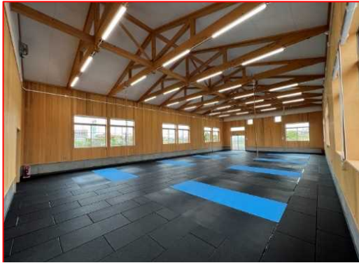
木造公共施設
