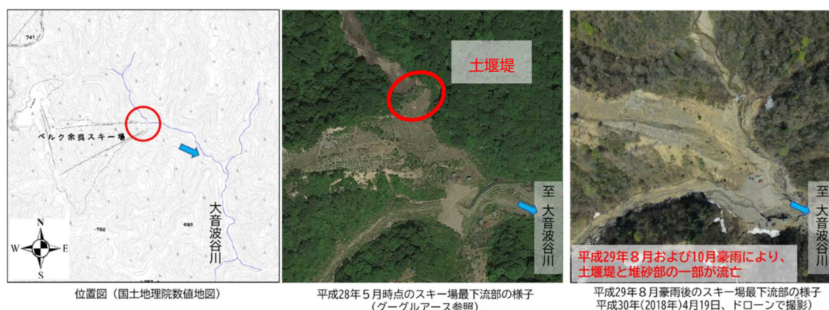
図2： 平成29年8月豪雨による、スキー場跡地の浸食状況
