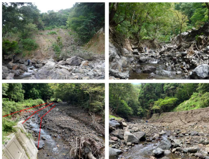
図 10： 現地踏査状況（針川）
