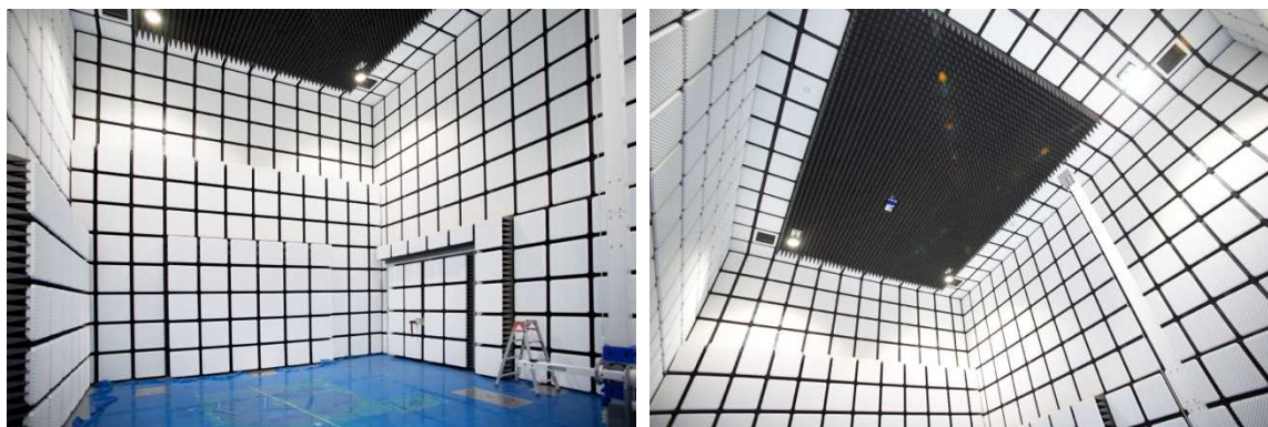
工事中の電波暗室内
