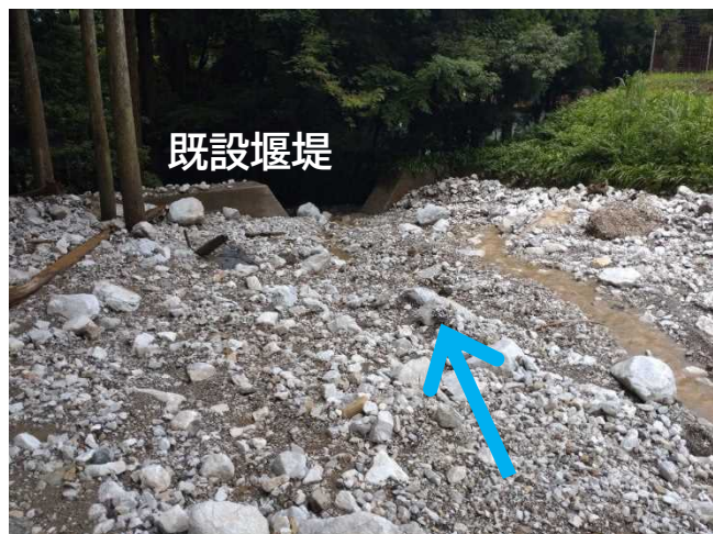
既設堰堤上流の土砂堆積状況 (7月1日)
