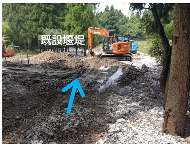
土砂撤去状況 (7月2日から着手)
