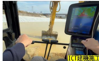
ICT建機施工
