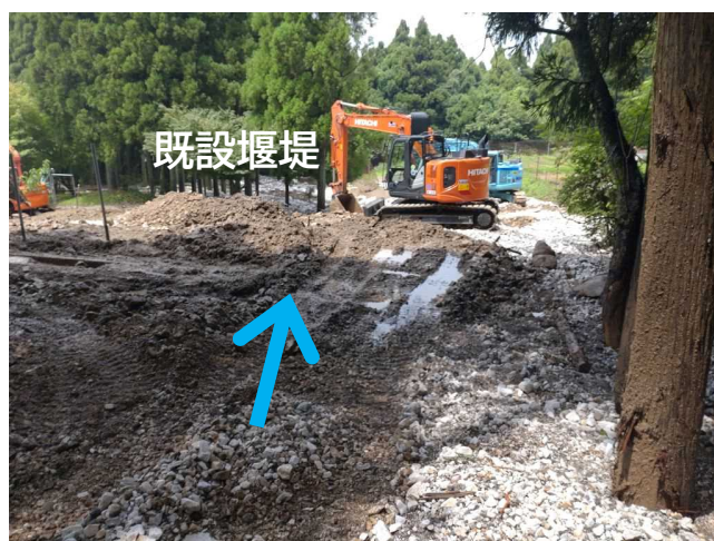
土砂撤去状況 (7月2日から着手)
