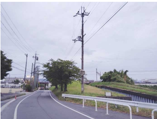
例：河川占用許可を受けて設置されている電柱
