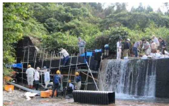
「小さな自然再生」の活動（仮設魚道の設置）
