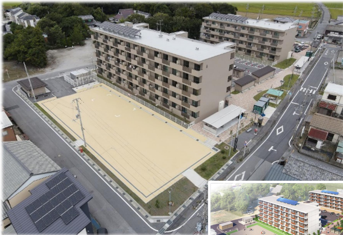
完成写真 (ドローンによる空撮)
