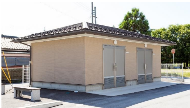
防災倉庫 (防災備品備蓄用)
