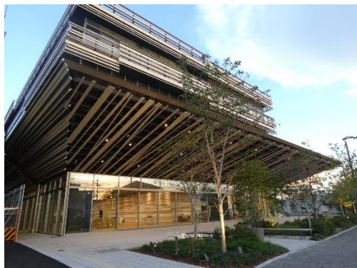
守山市庁舎（R5.8）新築・鉄骨造
