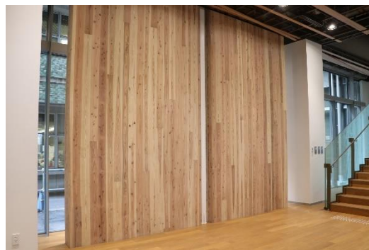
同左 耐力壁にCLT利用
