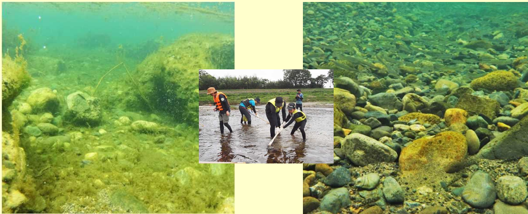
図.4-1 河床耕耘前(左)と耕耘後(右)
