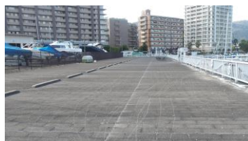
マリーナ桟橋取付護岸
