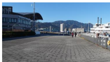
大型浮桟橋取付護岸
