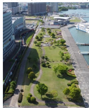
修景緑地(東側上空から全景)
