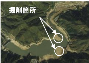
(ダム湖内掘削)
