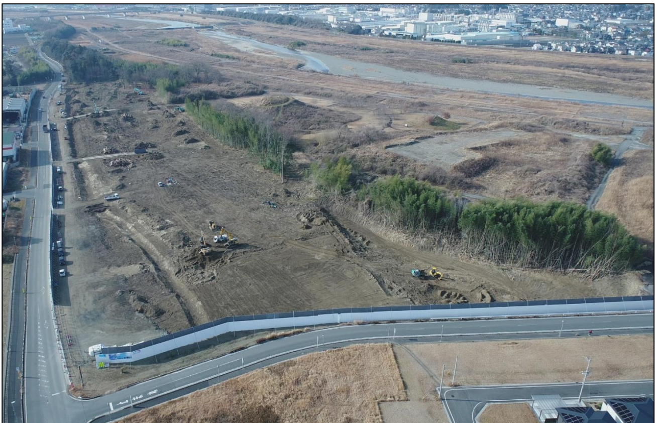
【造成工事の状況（令和7年2月3日時点）】
