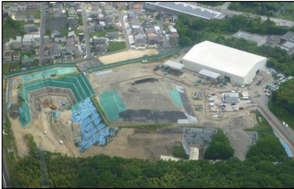
工事中(平成28年5月)の旧処分場
