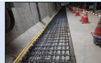
耐震補強工底盤増打 ▶
